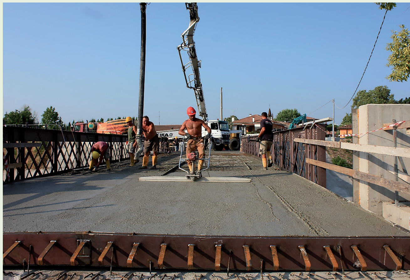
Ponte delle Motta, San Bonifacio (VR) - Argibeton LC 40/44
